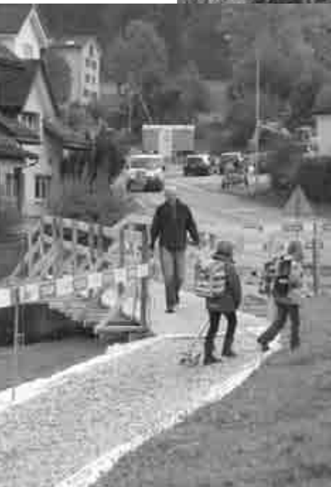
Für die Fussgänger wurde eine Notbrücke parallel zur abgebrochenen Brücke erstellt
