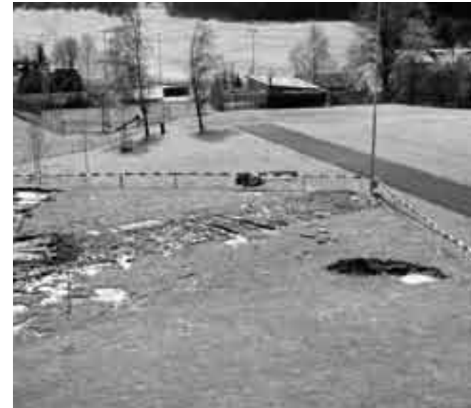
Hier, östlich des Schulhauses Lützelburg wird das Beach-Volleyballfeld errichtet.
