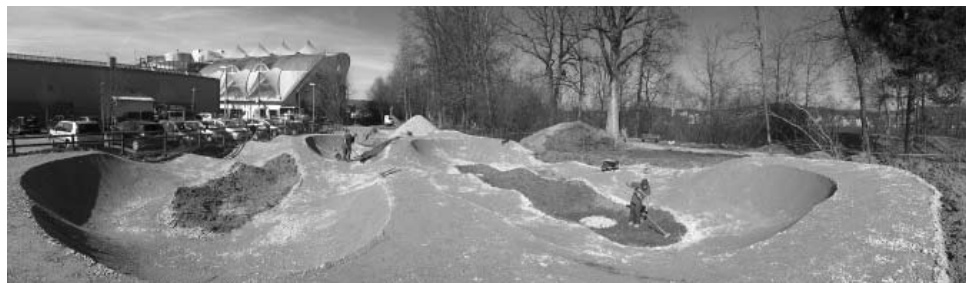
Nach den Baggerarbeiten musste die Strecke weitgehend in Handarbeit gestaltet werden.
