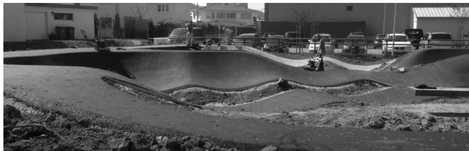
Am 30. März 2017 wurde dann die Asphaltsschicht aufgetragen. Schaufel für Schaufel...
