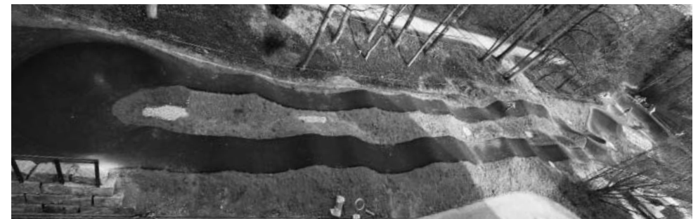
Blick auf die fertig asphaltierte Strecke mit ihren Wellen, Steilwandkurven und Plateaus.
