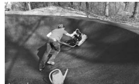
Letzter Feinschliff an der Asphaltdecke.
