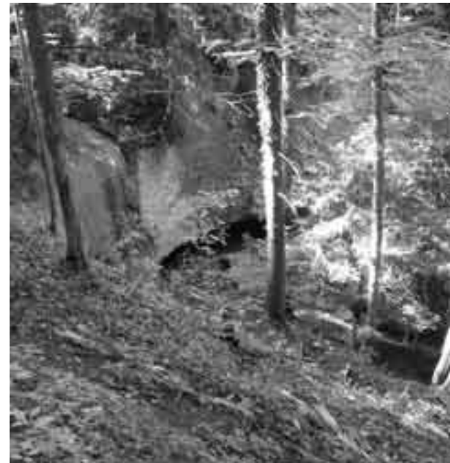
Zivilschutz Hinterthurgau hat den Zugang zum Tüfels Ofen saniert – trotzdem ist Vorsicht geboten
