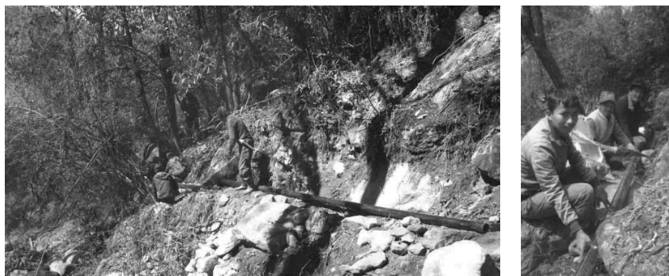
Der Bau der Leitung in schwierigem Gelände fordert den Arbeitern viel Schweiß ab.
