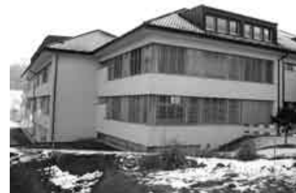
Die Ostfassaden des Schultraktes Lützelburg muss saniert werden
