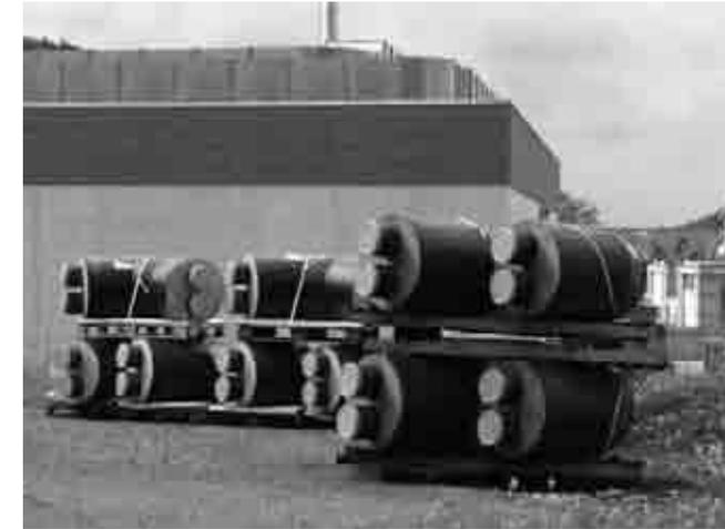
Sie liegen zum Einbau bereit: Fernwärmeleitungs-teile für den Neubau der Hauptleitung Richtung Dussnang
