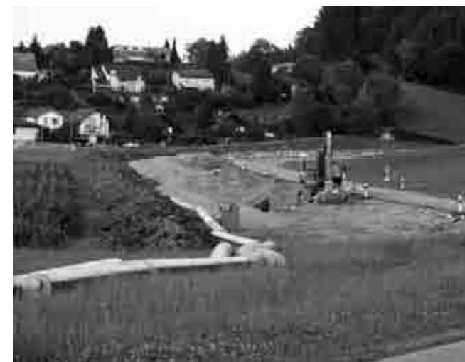
Fast könnte man glauben, die Fernwärme werde von Dussnang in unsere Gemeinde geliefert.
