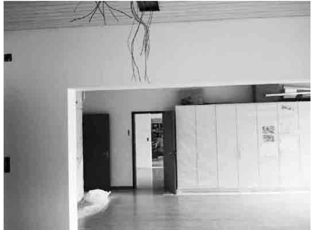
Nachdem die neue Verkleidung des Durchbruchs angebracht war, konnten sich die Elektriker hier an die letzte Etappe der Lampeninstallation machen.
