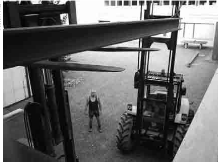
Eine knifflige Aufgabe einmal mehr souverän gemeistert: Markus Hubmann dirigiert den massiven Stahlträger ins Schulhaus
