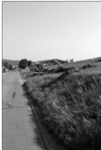
Beim Radwegbau zwischen Balterswil und Itaslen ist die zweite Etappe in Angriff genommen worden
