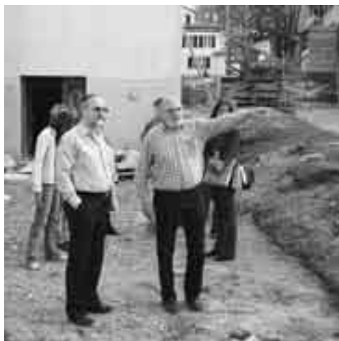
Die Behörde liess sich anlässlich einer Sitzung von Baupräsident Erich Schanderhazi (rechts) über den Stand der Arbeiten orientieren
