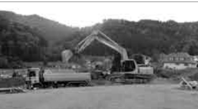
Zur Zeit wird der Strassenunterbau mit einer ca. 50 cm dicken Kiesschicht erstellt. Anschliessend sollen noch die fehlenden Randabschlüsse, die Strassensammler sowie die Beleuchtungskandelaber versetzt werden. Dank dem wunderschönen Herbstwetter soll laut Auskunft des Ingenieurbüros Fritschi & Ehrhardt AG Eschlikon noch vor Weihnachten der Belag eingebaut werden. Mit dem Bau der geplanten Wohnhäuser kann anschliessend, d.h. bereits anfangs 2006 begonnen werden. Die
