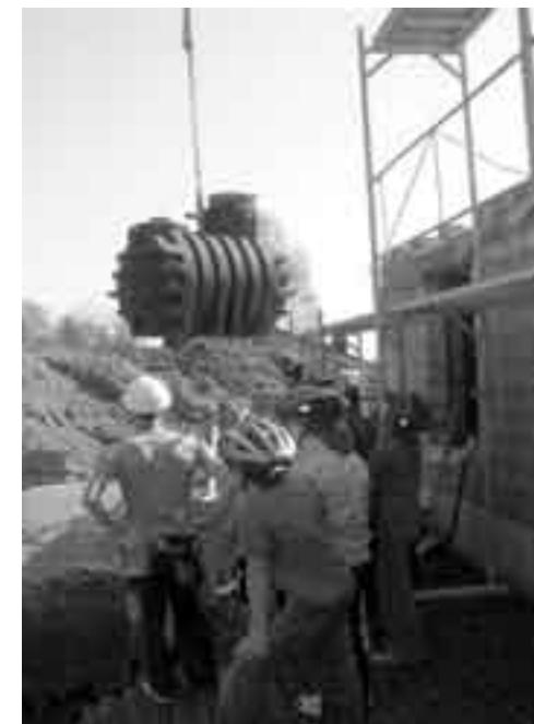
PE-Erdspeicher wird in die vorbereitete Baugrube eingebracht.
