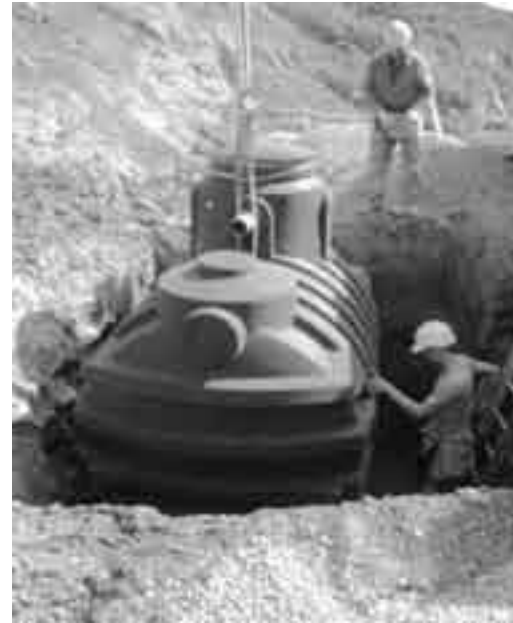
PE-Erdspeicher wird in die vorbereitete Baugrube eingebracht.
