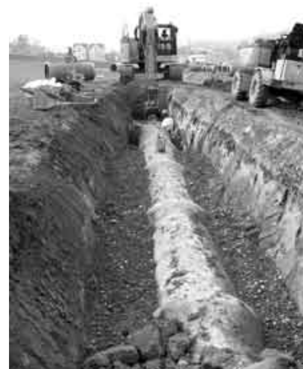
Bei nur 4,5 mm Gefälle auf einen Laufmeter Kanalrohr ist beim Bau des Regenwasserkanals in der Ribli Präzisionsarbeit gefragt. Eingesetzt wird dazu auch ein Lasergerät (unten).
