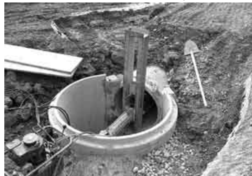
Bei nur 4,5 mm Gefälle auf einen Laufmeter Kanalrohr ist beim Bau des Regenwasserkanals in der Ribli Präzisionsarbeit gefragt. Eingesetzt wird dazu auch ein Lasergerät (unten).
