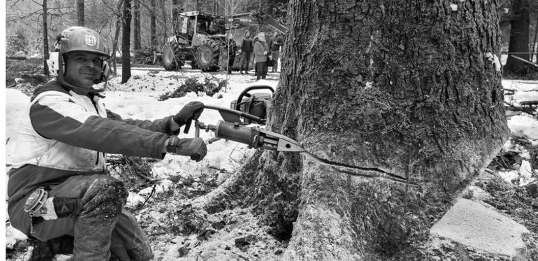
Die Fällkerbe ist gesägt, der Hydraulikkeil gesetzt. Kurz darauf schallte es: «Achtung! Baum fällt!»
