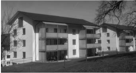
Waldsiedlung 2, Balterswil 2 ½-Zimmer-Dachwohnung
