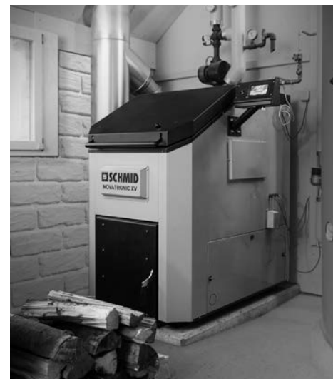
Saubere Sache: In einer Holzzentralheizung wird die Verbrennung technisch optimal gesteuert – zugunsten sehr niedriger Emissionswerte.
