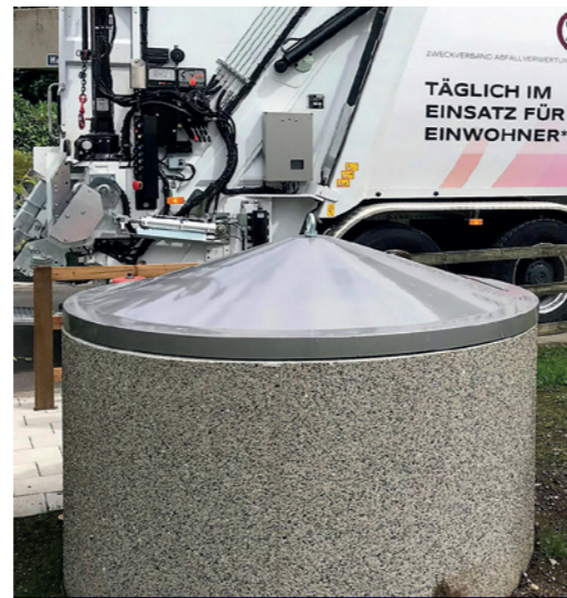
Bis auf einen fehlenden Standort in Bichelsee sind nun alle Unterflurbehälter erstellt.
