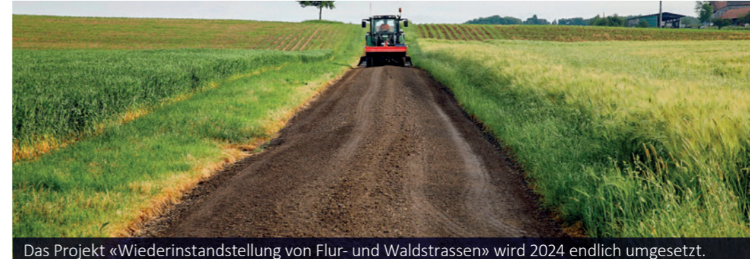
Das Projekt «Wiederinstandstellung von Flur- und Waldstrassen» wird 2024 endlich umgesetzt.
