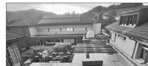
Baufortschritt Schulhaus Lützelburg
