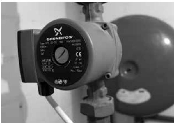
Seit 2013 sind gemäss Energieverordnung Pumpen der alten Technologie nicht mehr für den Verkauf zugelassen und sogenannte Hochwirkungsgrad-Pumpen mit elektronischer Drehzahlregelung vorgeschrieben. Allein dank des besseren Wirkungsgrads sparen sie gegenüber veralteten Geräten bis zu 80 Prozent Strom. Weitere Aspekte für ihren effizienten Einsatz sind die richtige Dimensionierung und die bedarfsgerechte Regelung. Das Heizungsregelsystem muss die Pumpe abschalten, wenn keine Wärme benötigt wird.
